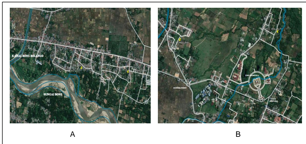
Gambar 1 A) IPAL komunal di desa Dutohe Barat dan Desa Tanggilingo Kecamatan Kabila; B: IPAL komunal di desa Butu dan Desa Iloheluma Kecamatan Tilongkabila
